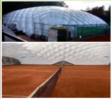
2-Platz Traglufthalle im Winter
